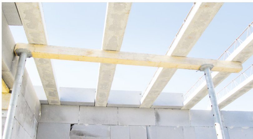
Podpěření stropních nosníků
