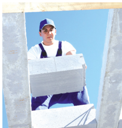
Ukládání stropních vložek
