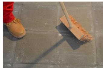
Pro ochranu betonu v místech vystavení povětrnostním vlivům a dešti je vhodné na adekvátně připravené beton použít tekutou hydroizolaci (Tekutá lepenka 2K) ve 2 a 3 vrstvách. Pokud je kamenný koberec aplikován na terasy a balkóny, provedení hydroizolace je nutné a také je nutné správné napojení na oplechování za pomoci fleeceband pásku, vytažení hydroizolace na stěnu ( do výšky 10-15 cm). Jakékoli prostupy hydroizolací je nutno řádně utěsnit (prostupy zábradlím, atd.)
